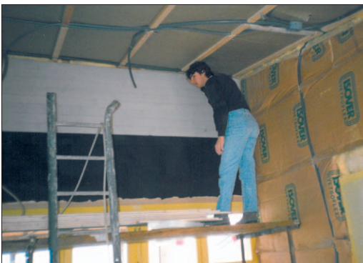
Viel Fronarbeit wurde für das FCG-Clubhaus geleistet (hier im April 1988)
